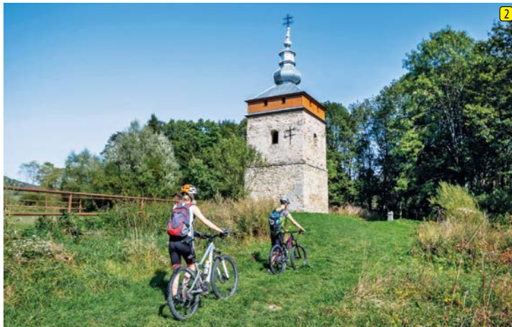
Renovated bell tower in Polany Surowiczne
