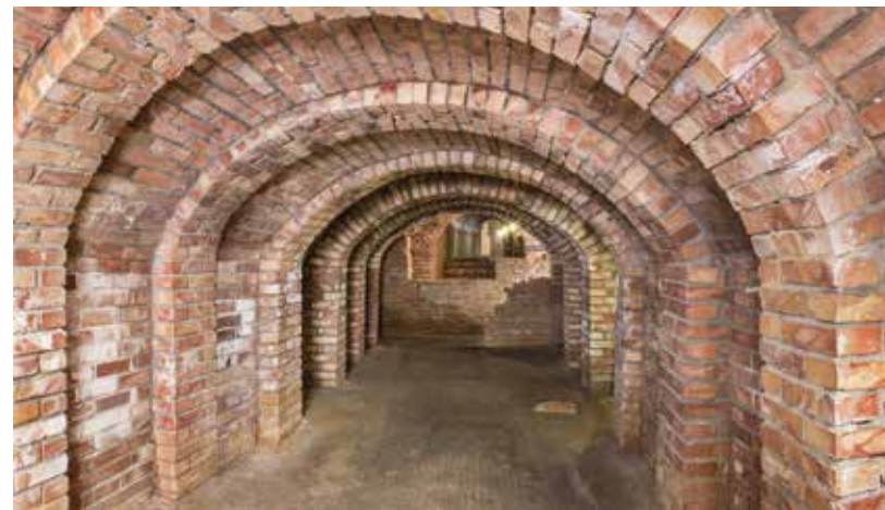
Podziemna Trasa Turystyczna w Rzeszowie, fot. J. Stankiewicz
