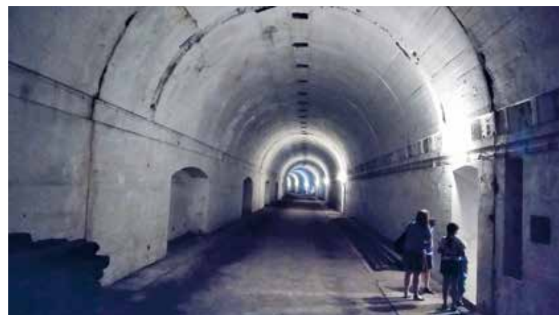
Schron kolejowy w Stępinie-Cieszynie, fot. Wyd. Compass
