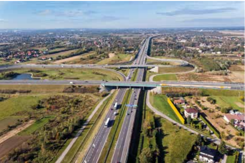
Węzeł autostradowy Rzeszów Wschód, fot. T. Trulka
