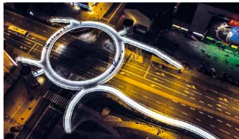
Okrągła kładka dla pieszych nad ul. Piłsudskiego, fot. Skanska SA
